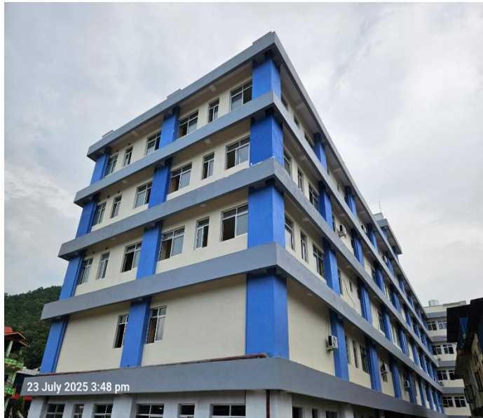
हेटौडा अस्पतालको भवन निर्माण ,हेटौडा
