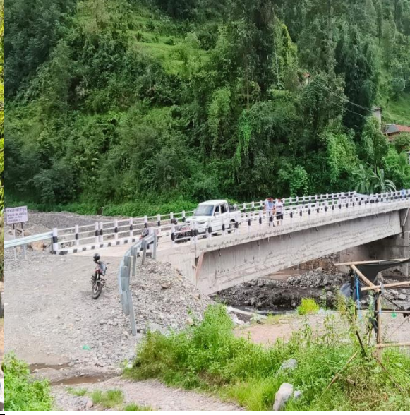
तामजोर खोला पक्कीपुल ,घ्याङखोला गा.पा.- ३,सिन्धुली निर्माण कार्य सम्पन्न
