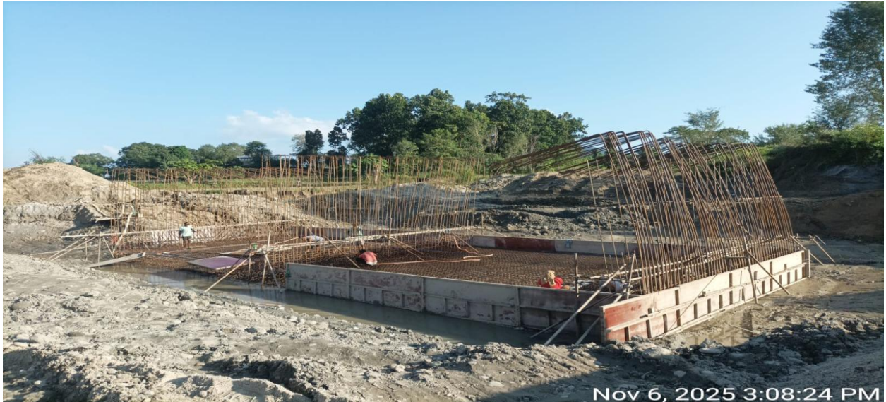
भालुनाला पुल ,मादी-०८,चितवन निर्माण कार्य भैरहेको
