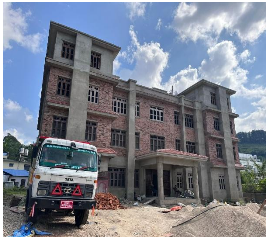
प्रादेशिक सडक डिभिजन तथा जि को .स.स. कार्यालय भवन निर्माण, सिन्धुली
