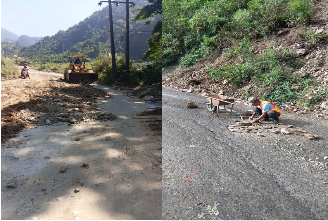
मकवानपुर जिल्ला अन्तर्गतका विभिन्न स्थलमा पहिरो हटाउने तथा सडक मर्मत कार्य
