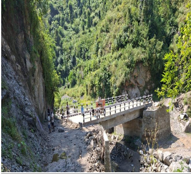
आरुबोटे खोला पुल, सुनकोशी-६ सिन्धुली
